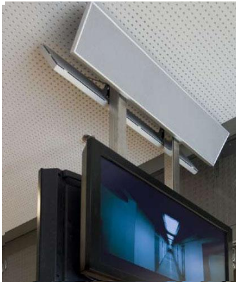
Рис. 11. Панфоникс установлен вместе с экраном
